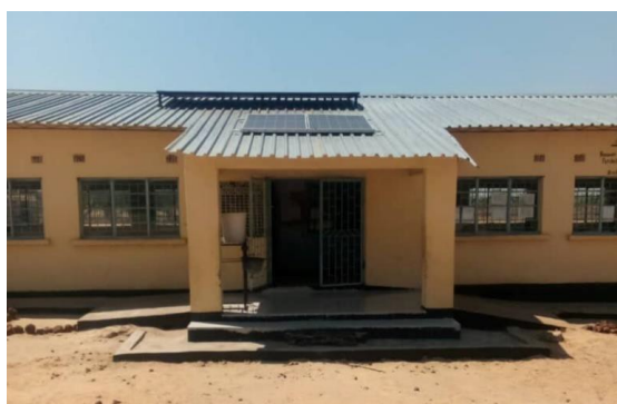
Namasheshe Primary School: er zijn lithiumbatterijen en twee zonnepanelen aan het systeem toegevoegd om de opwekkingscapaciteit te vergroten.
